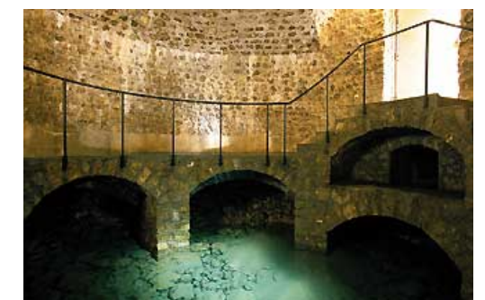
Figure 17 : Source d'Erigny (28) alimentant l'aqueduc de l'Avre
